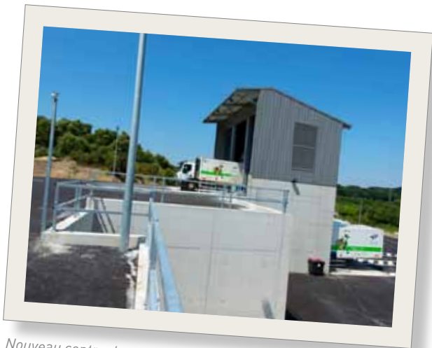
Nouveau centre de transfert des déchets à Kérolzec à Saint-Martin-Des-Champs inauguré le 6 septembre 2013.
