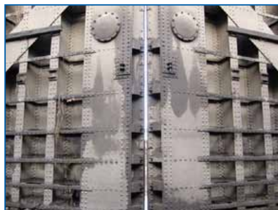
Portes d'écluse du port de Morlaix, lors du diagnostic réalisé en 2009
