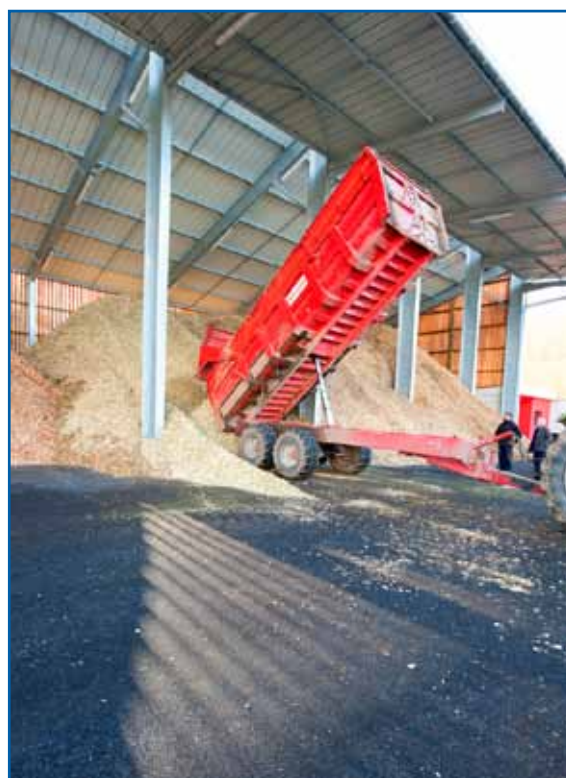
Plateforme bois énergie - Pleyber-Christ.
