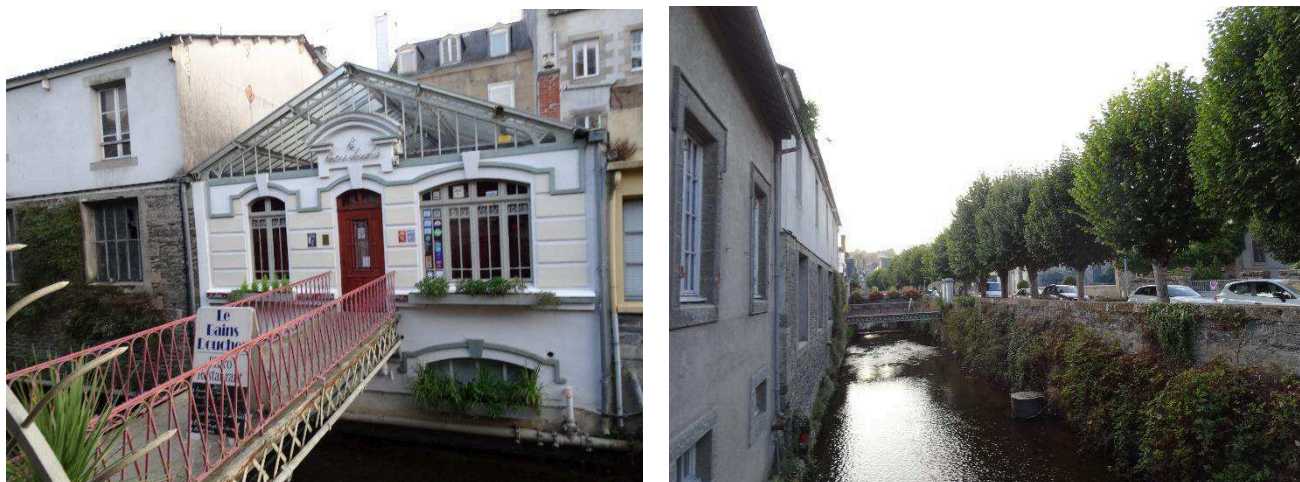
Figure 41 : Les passerelles du Jarlot, Source : MM 2014
