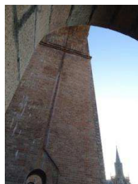
Une arche du viaduc
