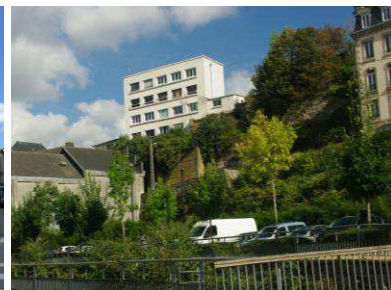
Bâtiment rue des vieilles murailles
