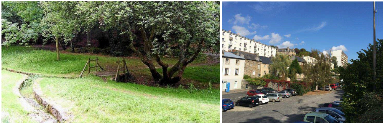
Figure 42 : Requalification des franges boisées, démolition du lit maçonné et reconstitution d'un lit naturel pour le ruisseau sont au programme des nouveaux aménagements de la vallée de Ty-Dour.
