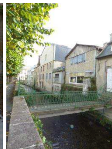
Passerelle sur le Jarlot
