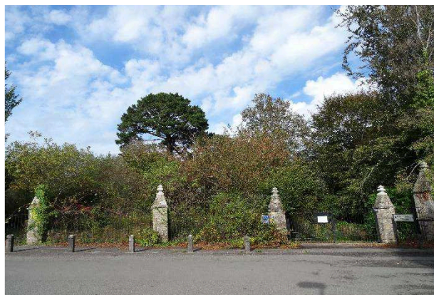
Figure 32 : enceinte du parc, Source : MM 2014
