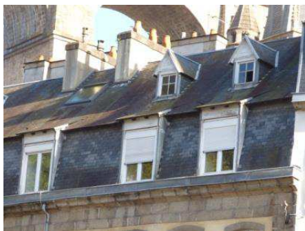
Percement sur 2 niveaux et de taille plus importante, les combles ne fonctionnent plus réellement comme un espace Tampon
