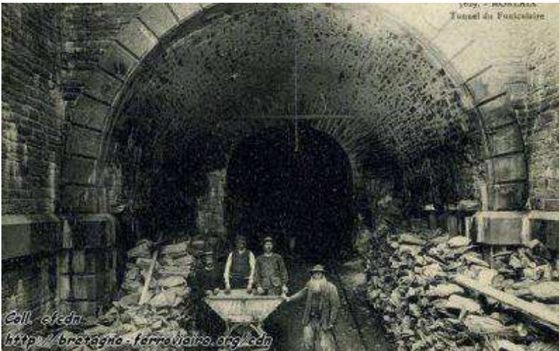
Figure 27 : Creusement du tunnel pour le funiculaire, Source : Bretagne-ferroviaire.org
