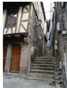
Rampe du Créou
