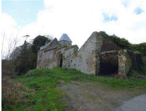
Figure 36 : Ruines, Source : MM 2014
