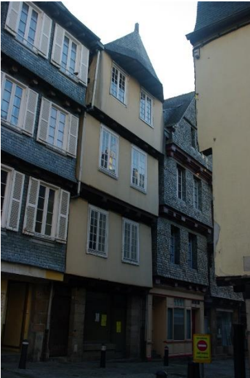
Façade plan à cour ouverte enduite – 45, rue Ange de Guernisac
