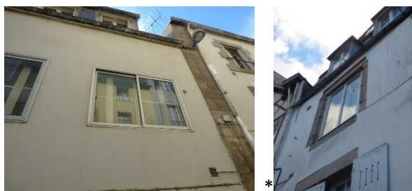
A EVITER – la double fenêtre extérieure
