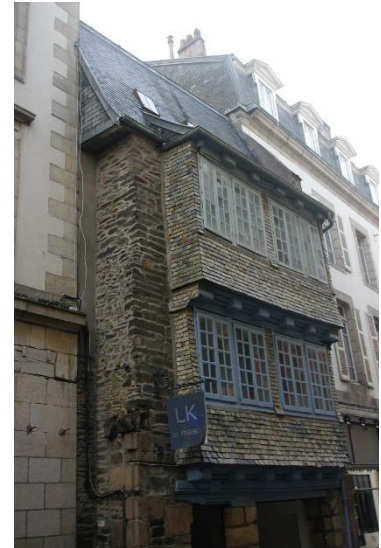
Façade en ardoises 3, rue du Pont Notre Dame
