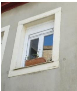
A EVITER – modification de la profondeur des ouvertures et l'accentuation du débord sur rue
