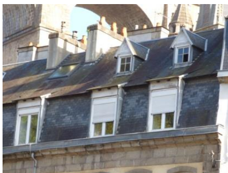
Percement sur 2 niveaux et de taille plus importante, les combles ne fonctionnent plus réellement comme un espace Tampon
