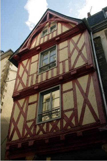
Fenêtre à la française + pan de bois apparent – 9, rue du mur
