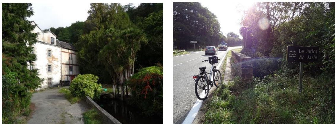
Figure 11 : Le Jarlot, au Val rouge, et pont route de Callac
