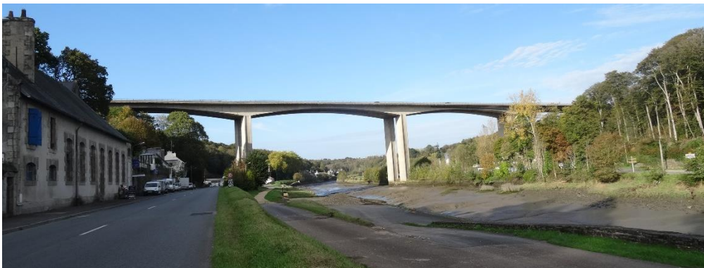
Figure 29 : Pont routier construit en 1970, Source : MM 2014
