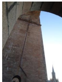
Une arche du viaduc
