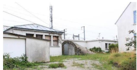
Emergence actuelle du tunnel
