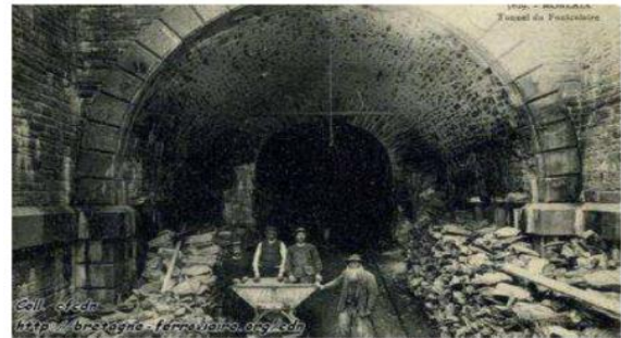
Figure 27 : Creusement du tunnel pour le funiculaire, Source : Bretagne-ferroviaire.org
